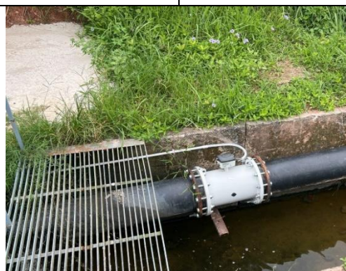
รูปที่ 2-5 เครื่องวัดอัตราการไหลของน้ำทิ้งและเครื่องวัดค่า COD ที่จุดปล่อยน้ำทิ้งจากบ่อกัก
