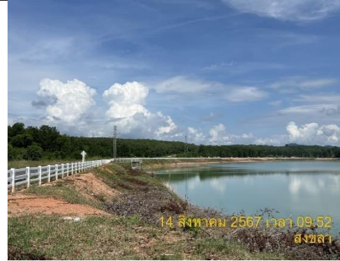
(2) อ่างเก็บน้ำดิบแห่งที่ 2 (ความจุ 1,600,000 ลบ.ม.)
