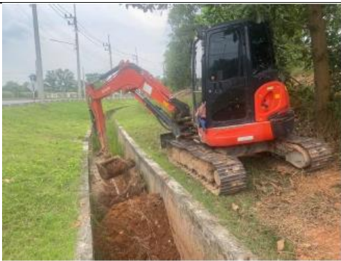
รูปที่ 2-2 การขุดลอกท่อระบายน้ำเสียและรางระบายน้ำฝนและบ่อฝัง
