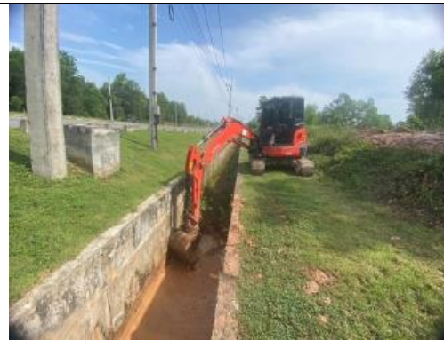
รูปที่ 2-2 การขุดลอกท่อระบายน้ำเสียและรางระบายน้ำฝนและบ่อฝัง
